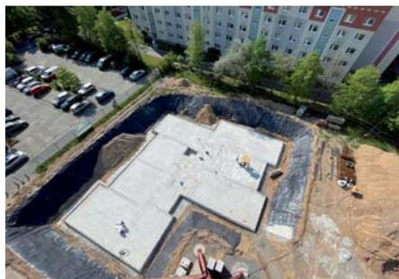
Aus dem ersten Spatenstich wurde eine Baugrube mit einer 50 cm starken Bodenplatte...
